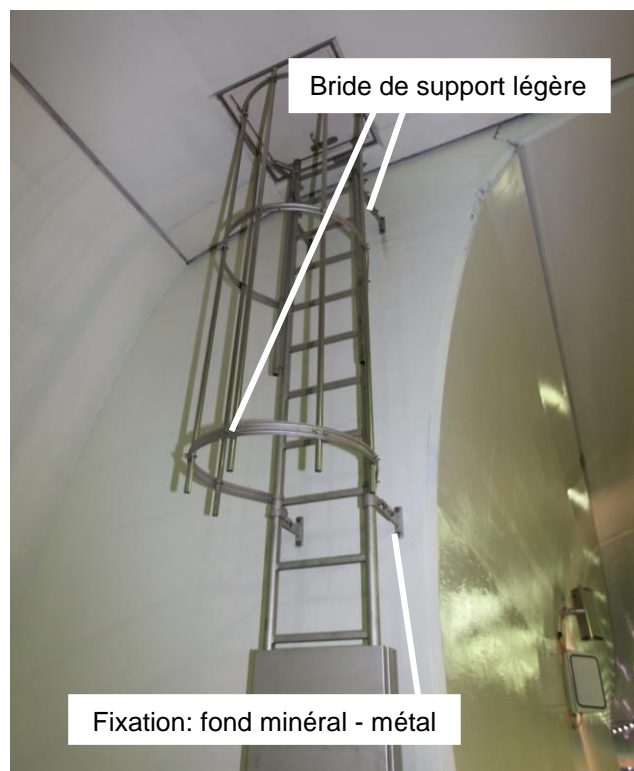
Illustration 20: échelle murale à cage de sûreté
