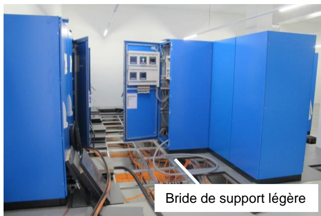
Illustration 17: placards d'installations électriques sur double fond
